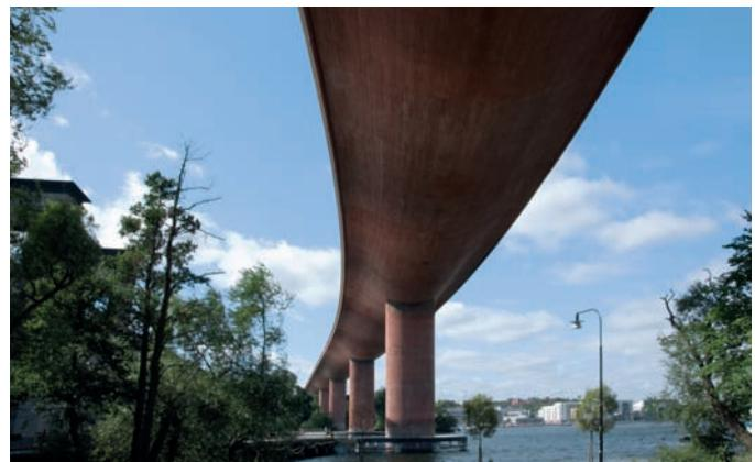
Betoniert wurde auf einer 130 m langen Bauplattform, die an den bereits fertig gestellten Abschnitten befestigt und auf den nächsten beiden Stützen aufgelagert wurde. Um große Farbtonvariationen zu vermeiden, waren die Bretter der Schalung mit rot pigmentiertem Zement eingeschlämmt. Das Gießen dauerte 24 Stunden ohne Unterbrechung. Mehr als 300 m<sup>3</sup> waren dann in die Gießform eingepumpt.
