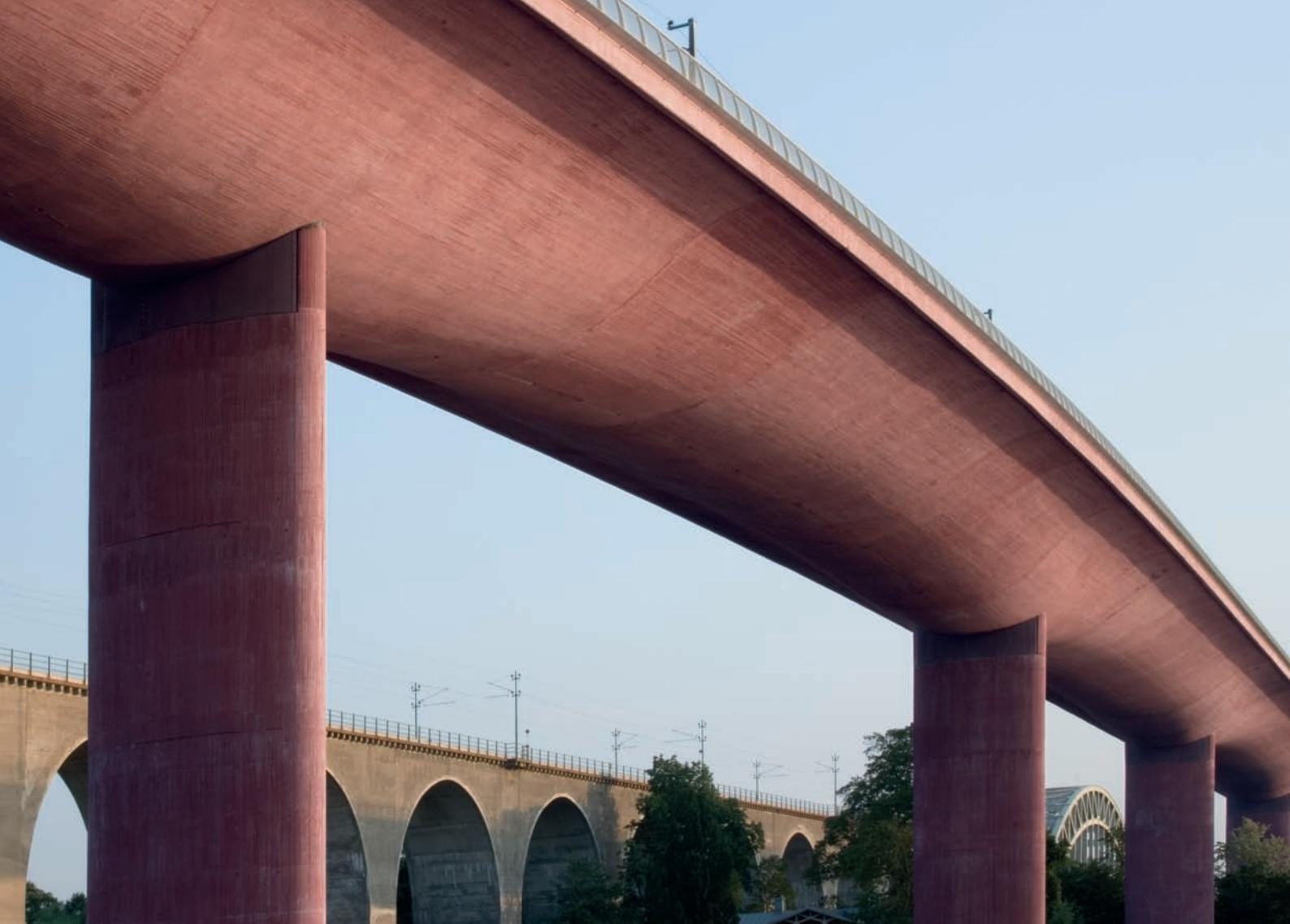
Für die rotbraune Einfärbung des Betons kamen 350 t Eisenoxid-pigmente zum Einsatz, eine Sondermischung auf Basis von Bayferrox® 640.
